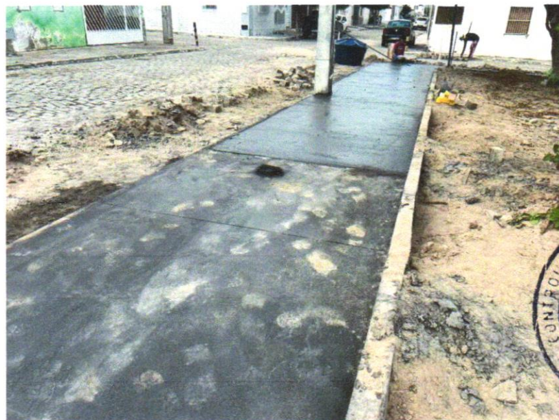
Foto 06 - PISO EM CONCRETO 20 MPA PREPARO MECÂNICO, ESPESSURA 7CM. AF_09/2020
