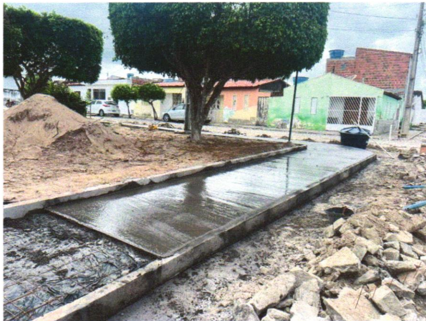
Foto 05 - PISO EM CONCRETO 20 MPA PREPARO MECÂNICO, ESPESSURA 7CM. AF_09/2020
