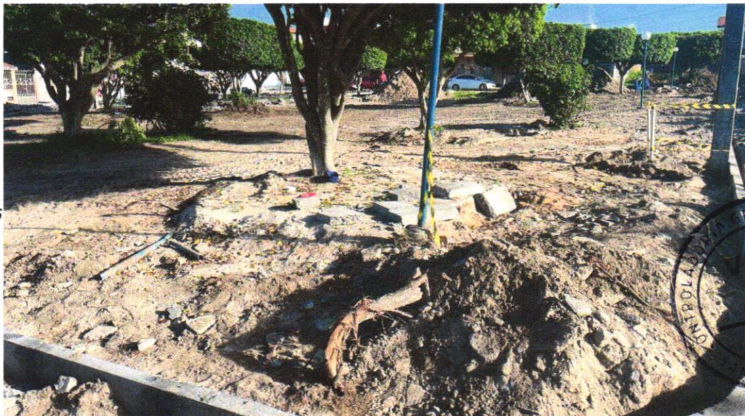
Foto 02 - LIMPEZA MANUAL DO TERRENO COM RASPAGEM SUPERFICIAL (CAPINAÇÃO)
