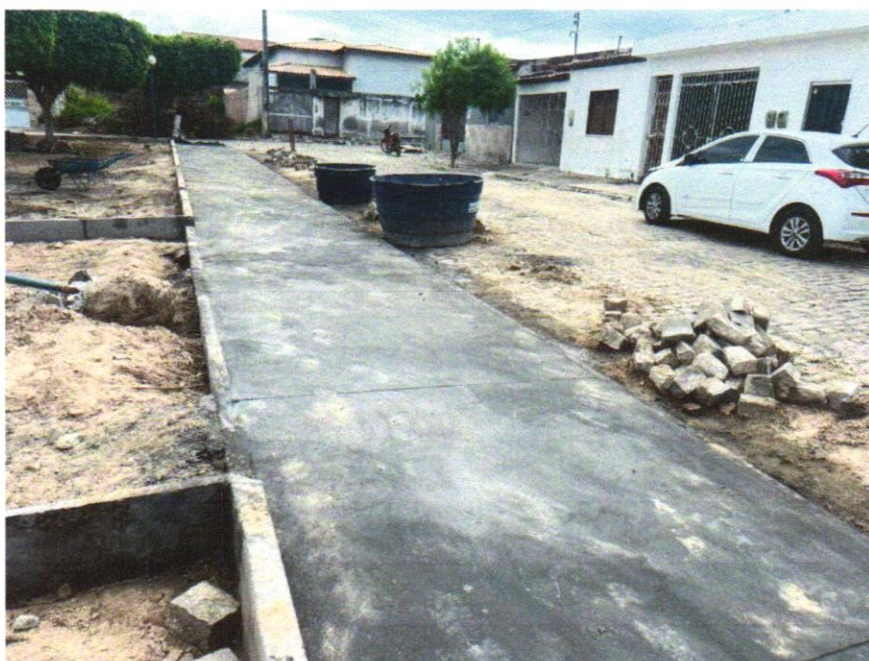
Foto 07 - PISO EM CONCRETO 20 MPA PREPARO MECÂNICO, ESPESSURA 7CM. AF_09/2020
