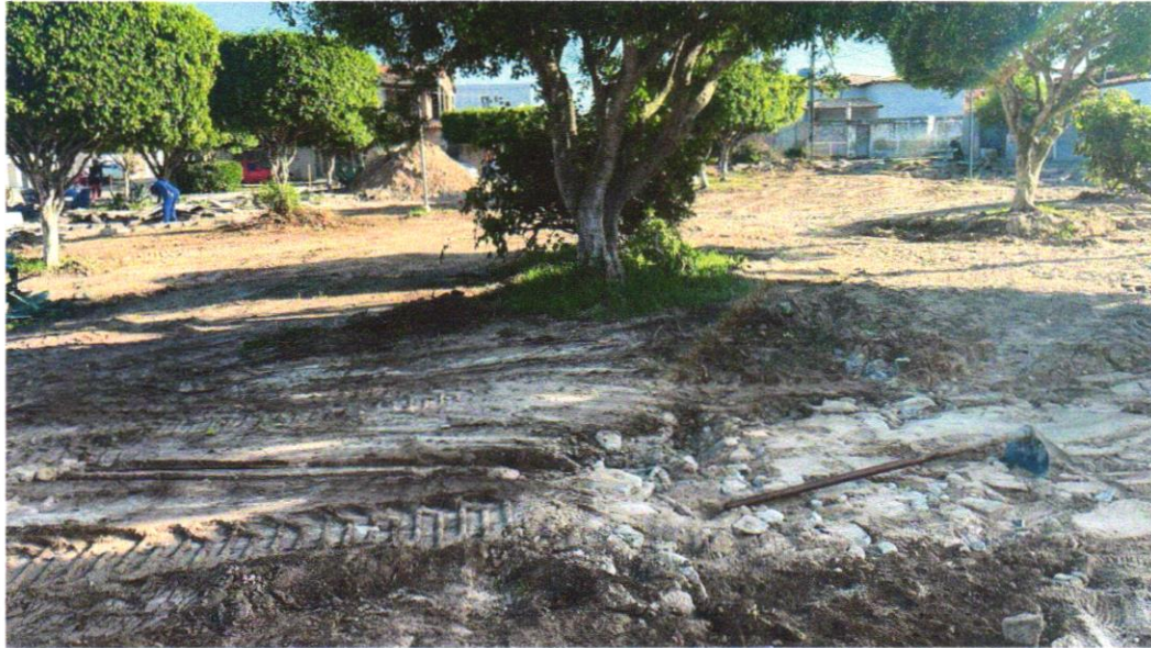
Foto 01 – LIMPEZA MANUAL DO TERRENO COM RASPAGEM SUPERFICIAL (CAPINAÇÃO)
